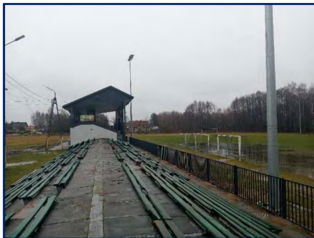
Rycina 27. Przykład obiektów w złym stanie technicznym na obszarze rewitalizacji: Stadion Miejski w Pilawie, Boisko sportowe w Trąbkach, boisko sportowe oraz plac sprawnościowy na terenie Szkoły Podstawowej im. Henryka Sienkiewicza w Pilawie
