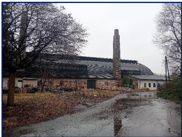
Rycina 25. Budynki należące do kompleksu Huty Szkła "Czechy" (Trąbki)
